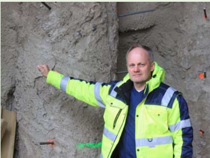
BM Dipl.-Ing. Stephan Bojer von der Massivbau ist sichtlich zufrieden mit dem Baufortschritt. Anfang Juni werden die gesamten Mittel- und Außenwände fertig sein.
